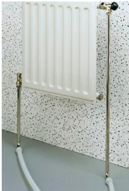
Снизу, с помощью латунных никелированных уголков USYSTEMS
