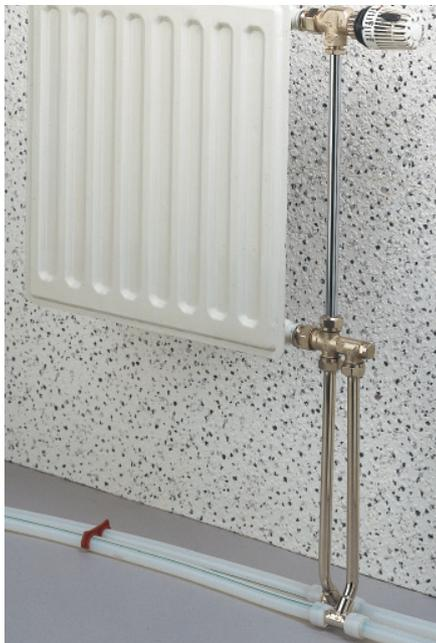
Снизу, с помощью латунных никелированных тройников USYSTEMS
