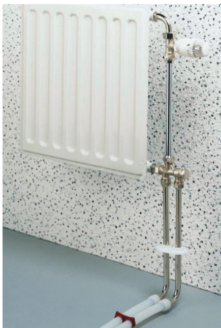
Снизу, с помощью латунных никелированных уголков USYSTEMS
