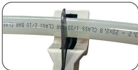
Отрежьте трубу под прямым углом. Не допускается наличие повреждений/загрязнений на конце трубы.
