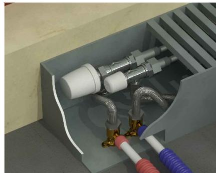
Минимальный радиус изгиба трубы Usystems PE-Xa зависит от диаметра и способа изгиба, см. таблицу; Для реализации меньших радиусов изгиба трубы Usystems PE-Xa используйте пластиковые фиксаторы угла или угольники;
